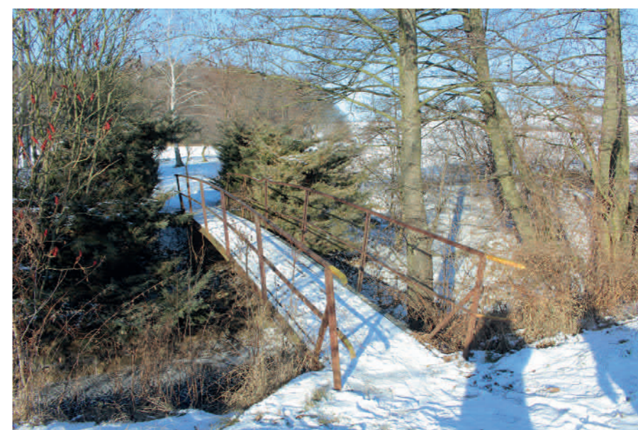
již stávající použití ocelového profilu
